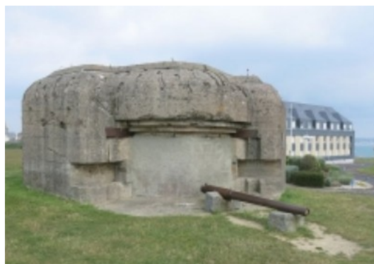
Batterie de la Pointe du Roc à Granville
