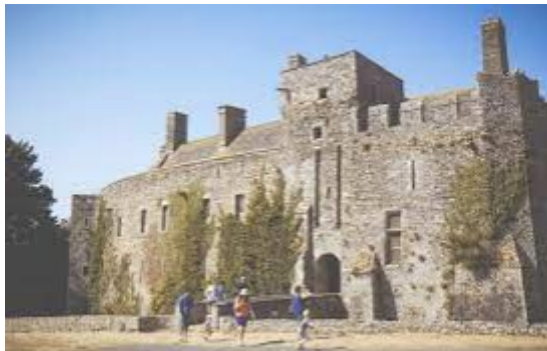
La tour carrée au-dessus de la porte – photo Côte Ouest Centre Manche Tourisme
